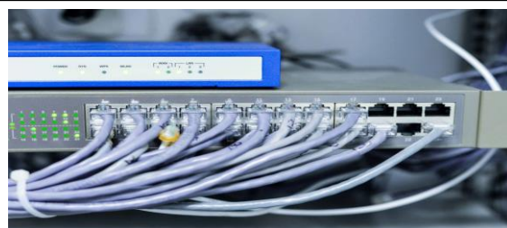
R 1.1.1.1.19 Instalación de Nodo para cabina de grabación CIAL - Se solicitaron 1 y se adquirió 1.
